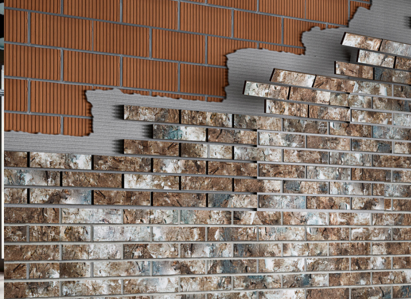
COLOCACION DE MALLA
